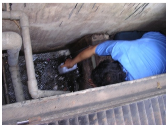
Gambar 2. Pengambilan Sampel Air di Bak Pengendap IPAL Lama
